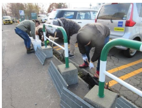
グレーチング清掃中
