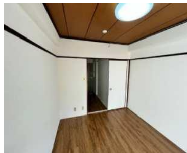
施工実績①
